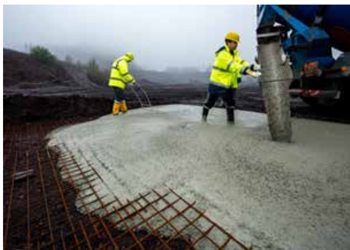
Obr.: 28 a Obr.: 29 Ukládání QCC
