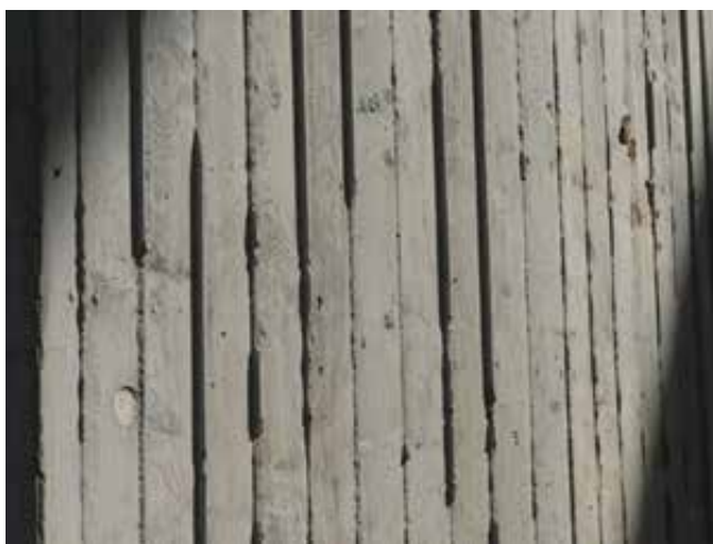
Obr.: 25 Stěna z SCC
