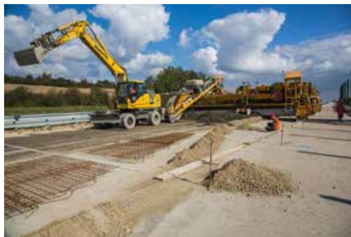
Obr.: 13 Pokládka dvouvrstvého CB I
