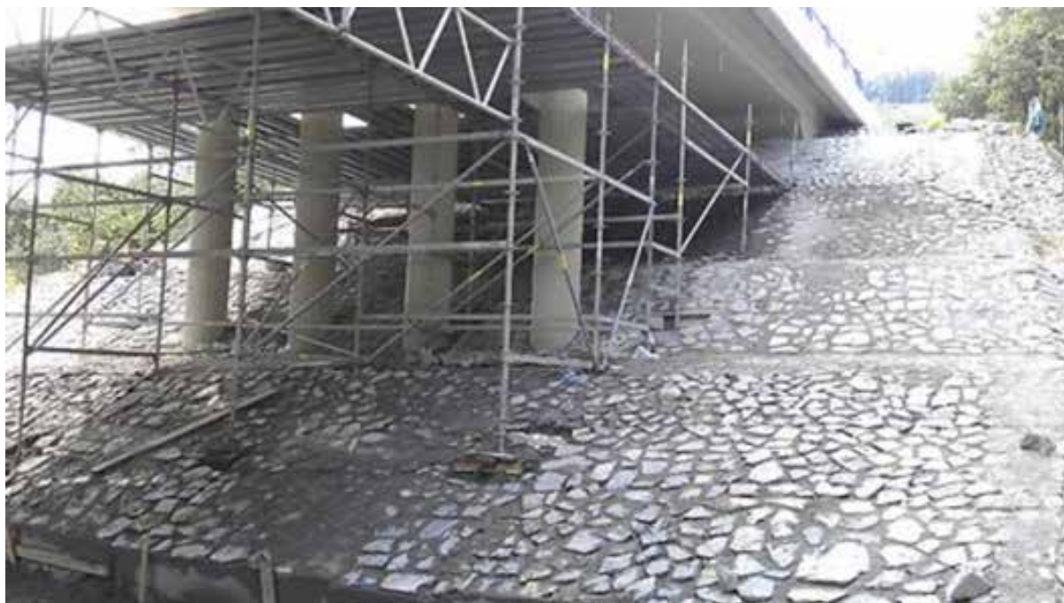
Obr.: 24 Dlažba pod mostem
