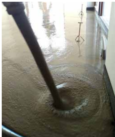
Obr.: 4 Ukládání ZAPA Slim
