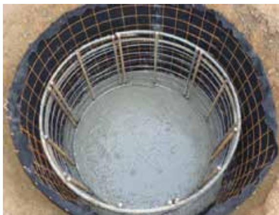
Obr.: 10 Zalitá pilota
