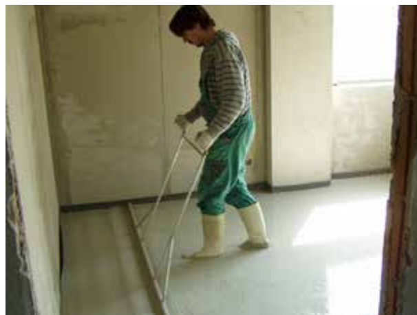
Obr. 2: Hutnění a srovnávání vrstvy ANHYSCREEDu
