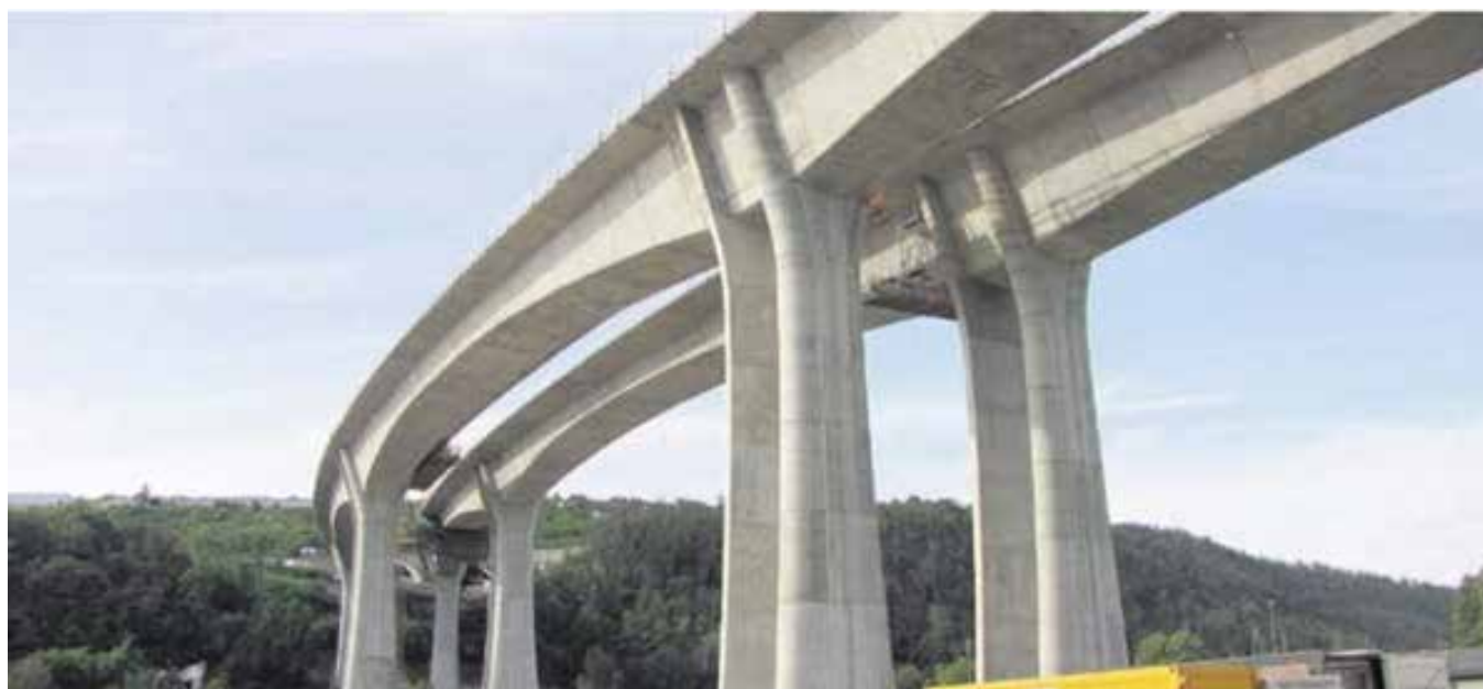
Obr.: 12 Dálniční most
