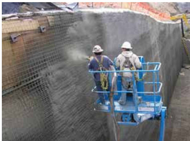
Obr.: 7 Torketování stěny
