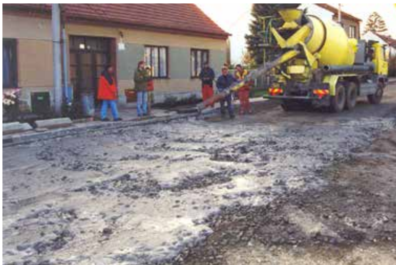
Obr.: 15 Rozprostírání ŠCM
