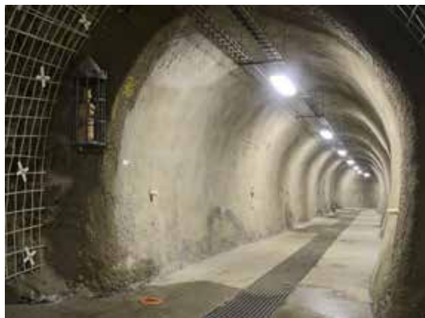
Obr.: 8 Stříkaná šachta
