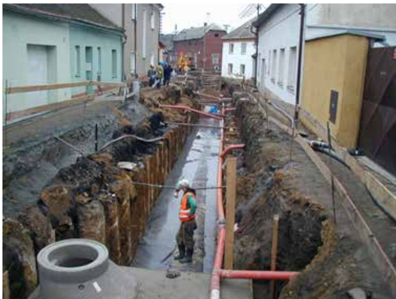
Obr.: 21 Potrubí zalité CPS
