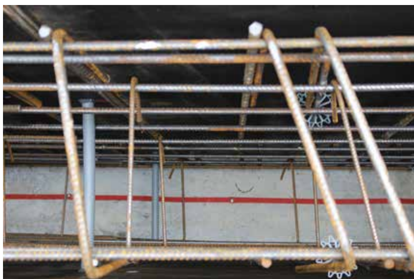
Obr.: 23 Těsnění pracovních spár
