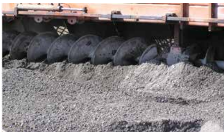
Obr.: 15 Ukládání KSC
