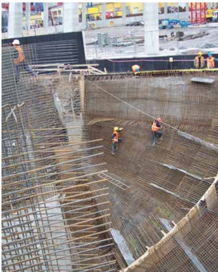
Obr.: 22 Bílá vana - silně vyztužená konstrukce
