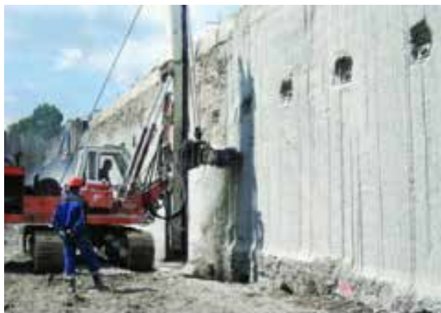
Obr.: 11 Podzemní stěna
