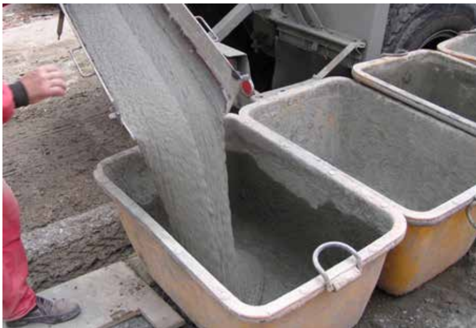
Obr.: 5 Doprava čerstvé malty na staveniště
