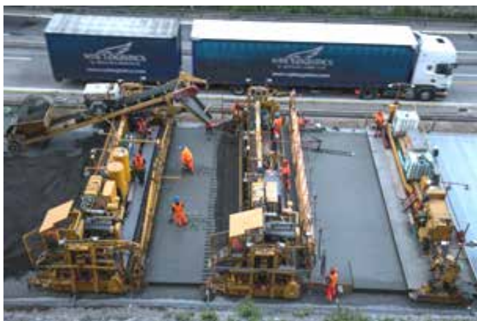
Obr.: 13 Pokládka dvouvrstvého CB I
