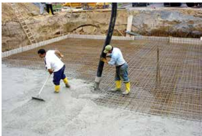
Obr.: 23 Ukládání SCC
