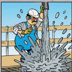
Zabraň rozmísení betonu. Zajišť, aby beton nepadal z výšky větší než 1,5 m.
