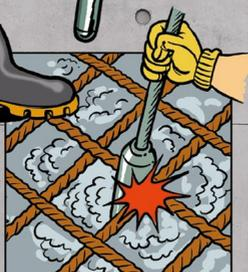
Zabraň kontaktu vibrátoru s výtuzí a bedněním.
