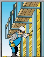
Průběžně kontroluj bednění a jeho styky.
