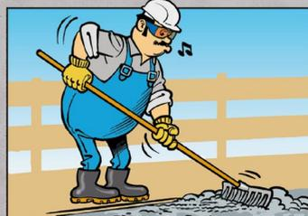
Je-li potřeba přemístit beton, použij lopatu nebo hrábě, v žádném případě ponorný vibrátor.
